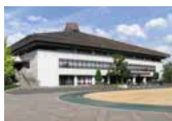
八幡市民体育館 外観
