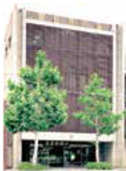
株式会社 小堀 本社・外観
