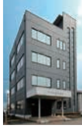
サント機工株式会社 本社 外観
