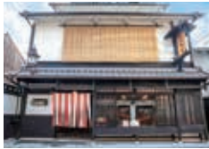
くろちく本店 天正館・外観
